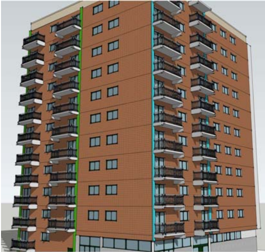
No 1 – Vue d'ensemble du bâtiment
