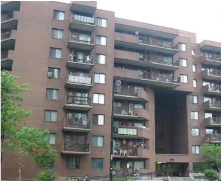
**D'importants travaux de près de 1,5 M\$ seront entrepris aux habitations Durocher, situées au 425, rue Sherbrooke Ouest. Ces travaux visent la réfection de la maçonnerie, la réparation des balcons et le remplacement des garde-corps des balcons ainsi que la modernisation du système de ventilation.**
